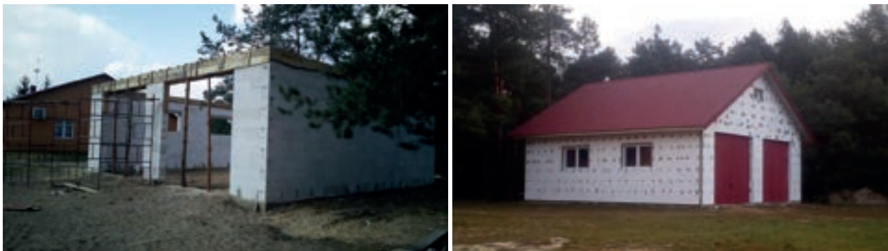
Fot. Budowa garażu strażackiego w Wołoskowoli
