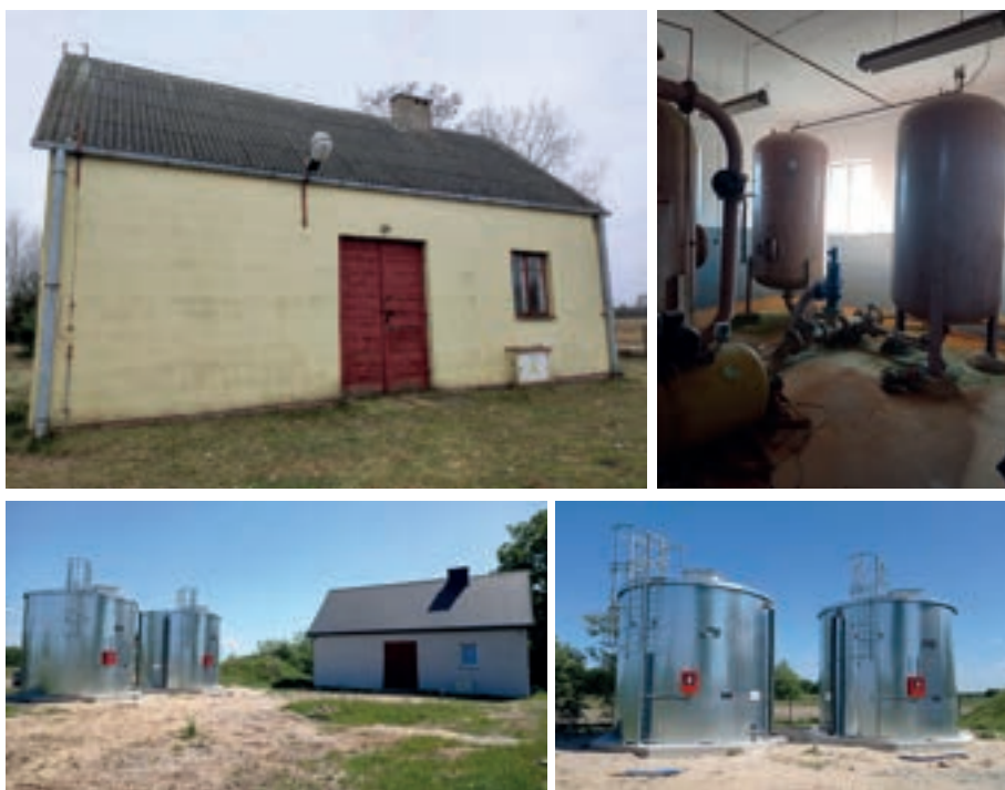
Fot. Stacja Ujęcia Wody w Wołoskowoli przed i w trakcie modernizacji
