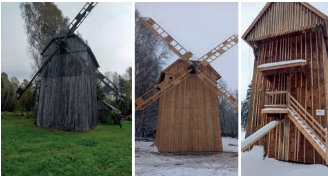
Fot. Wiatrak w Holi przed i po remoncie
